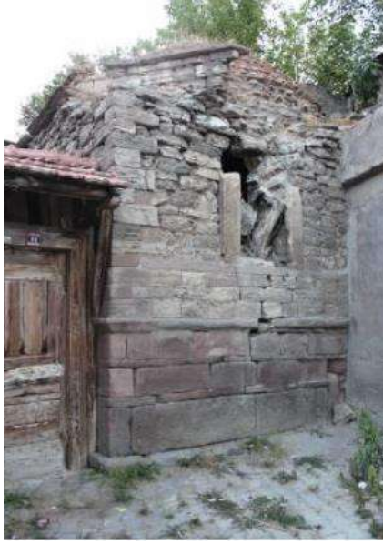
Şekil 22. Kütüphane doğu cephesi
