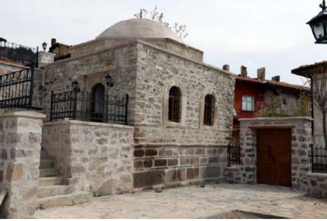
Şekil 47. Kütüphanenin yapı malzemeleri ve yapım teknikleri
