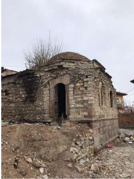
Şekil 9. Kütüphanenin restorasyondan önceki görünüşü
