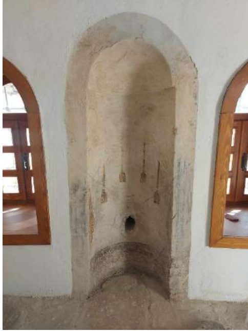
Şekil 42. Restorasyondan sonraki mihrap görünüşü
