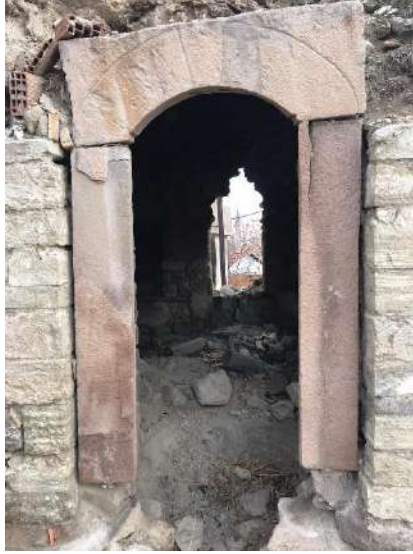
Şekil 18. Kütüphanenin restorasyondan önceki kapı görünüşü
