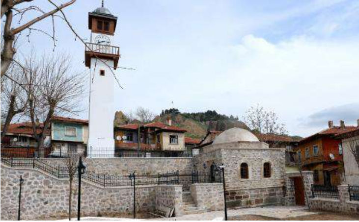
Şekil 11. Kütüphanenin günümüzdeki yapı malzemesi ve yapım tekniklerinin görünüşü
