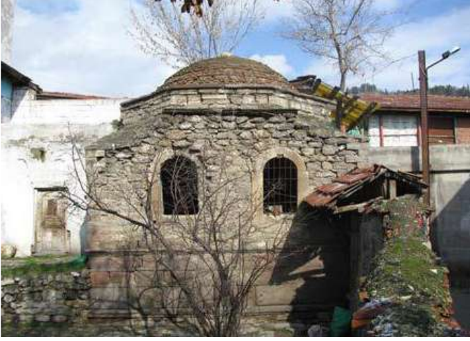
Şekil 8. Kütüphanenin restorasyondan önceki görünüşü
