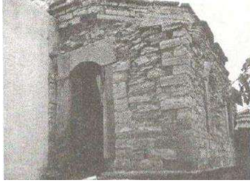
Şekil 15. Kütüphanenin restorasyondan önceki yapı malzemesi ve yapım tekniklerinin görünüşü
