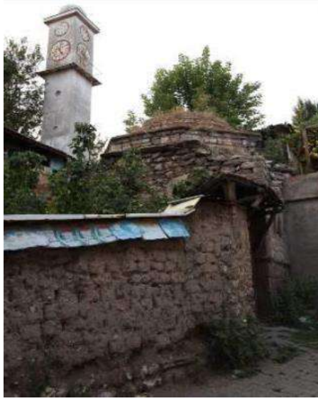
Ŗekil 19. Kütüphanenin restorasyondan önceki güneybatı görünüşleri
