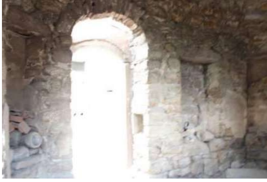
Şekil 36. Kütüphane batı duvar görünüşü
