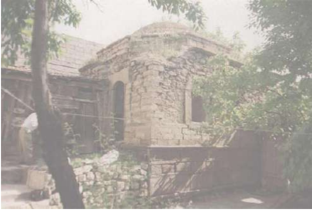
Şekil 21. Kütüphanenin restorasyondan önceki güneybatı görünüşü
