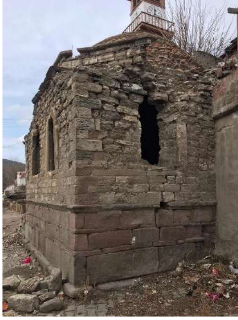
Şekil 10. Kütüphanenin restorasyondan önceki görünüşü
