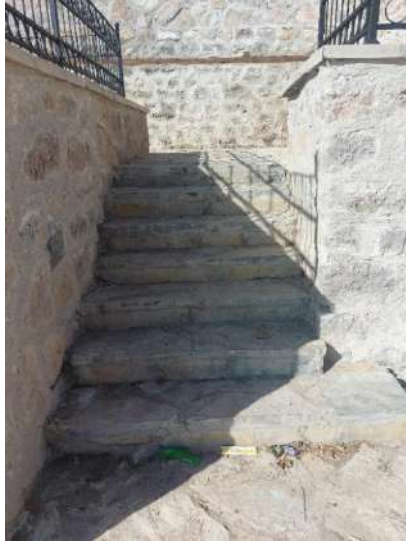
Şekil 13. Kütüphanenin restorasyondan sonraki merdivenin görünüşü
