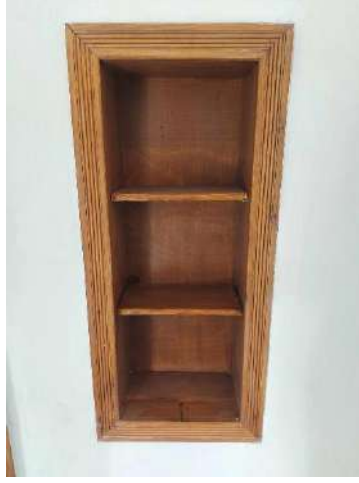
Şekil 43. Restorasyondan sonraki niş görünüşü
