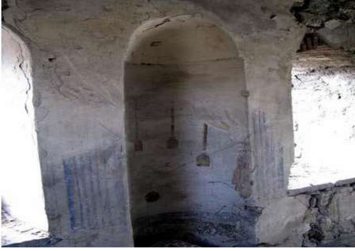
Şekil 41. Restorasyondan önceki mihrap görünüşü
