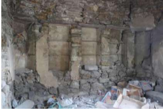
Şekil 31. Kütüphane kuzey duvar görünüşü
