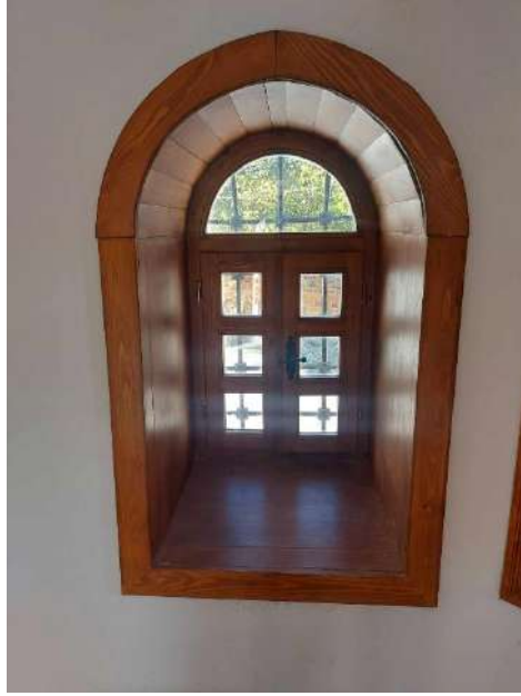
Şekil 17. Kütüphanenin restorasyondan sonraki pencerelerin görünüşü
