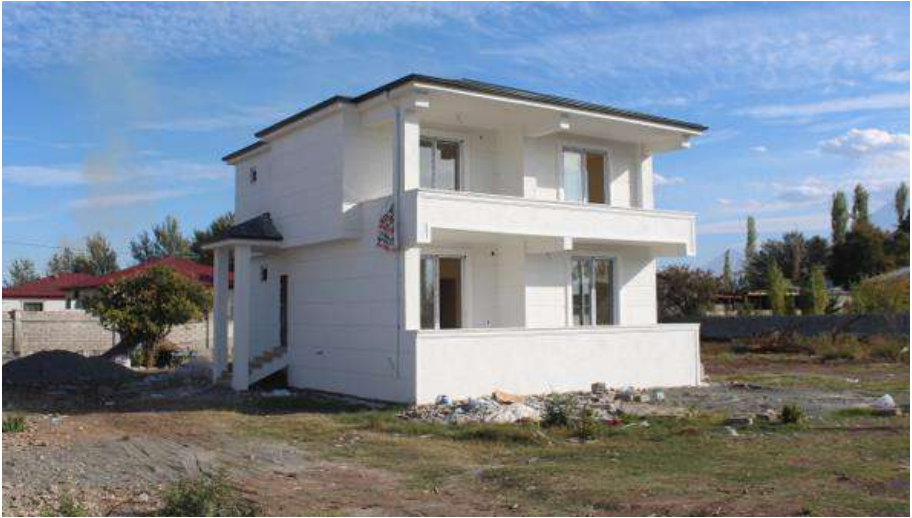
Şekil 4. Kacerdoğanşalı köyünde inşaatı henüz bitirilmemiş bir gurbetçi evi.
