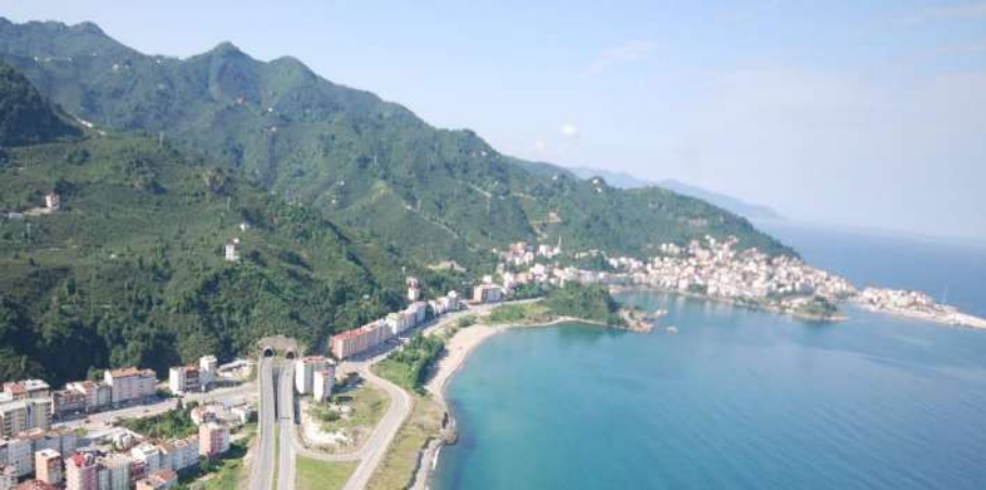
Şekil 5. Tirebolu Tünel Girişinin Doğudan Görünümü. 2008 yılında tamamlanan tünellerle transit araçlar adeta şehri pas geçmektedirler (Kaynak: Fatih Furkan Akkaya).
