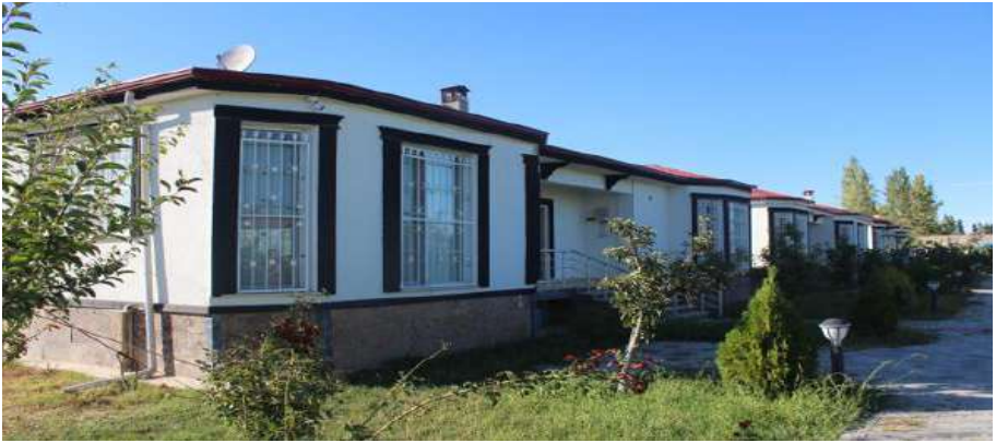
Şekil 9. Yayı köyünde aynı bahçe içerisinde inşa edilmiş üç gurbetçi evi.
