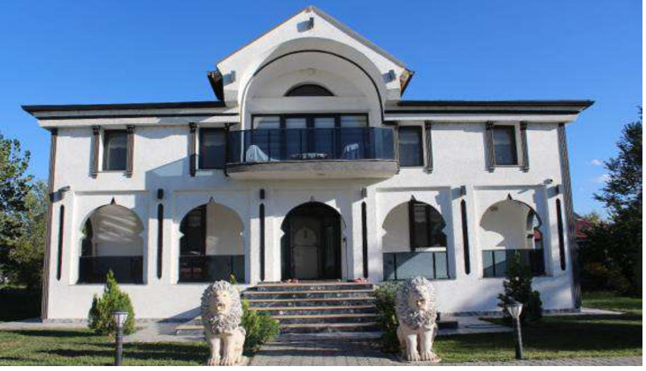
Şekil 13. Yaycı köyünde bulunan gurbetçi evinin ön cephesi.
