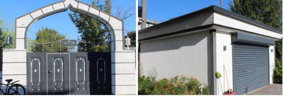
Şekil 14. Yaycı köyünde inşa edilmiş bir gurbetçi evinin girişi ve garajı.
