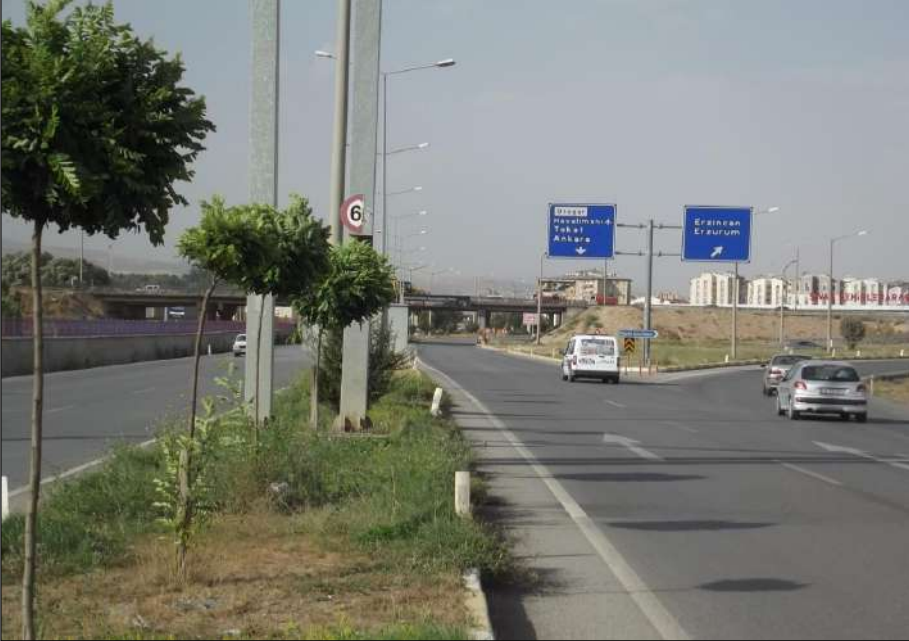
Fotoğraf 3.14: D-200 ve D-850 Karayollarının Sivas İl Merkezi'nden Kalan Kesiminden Görünümü.
