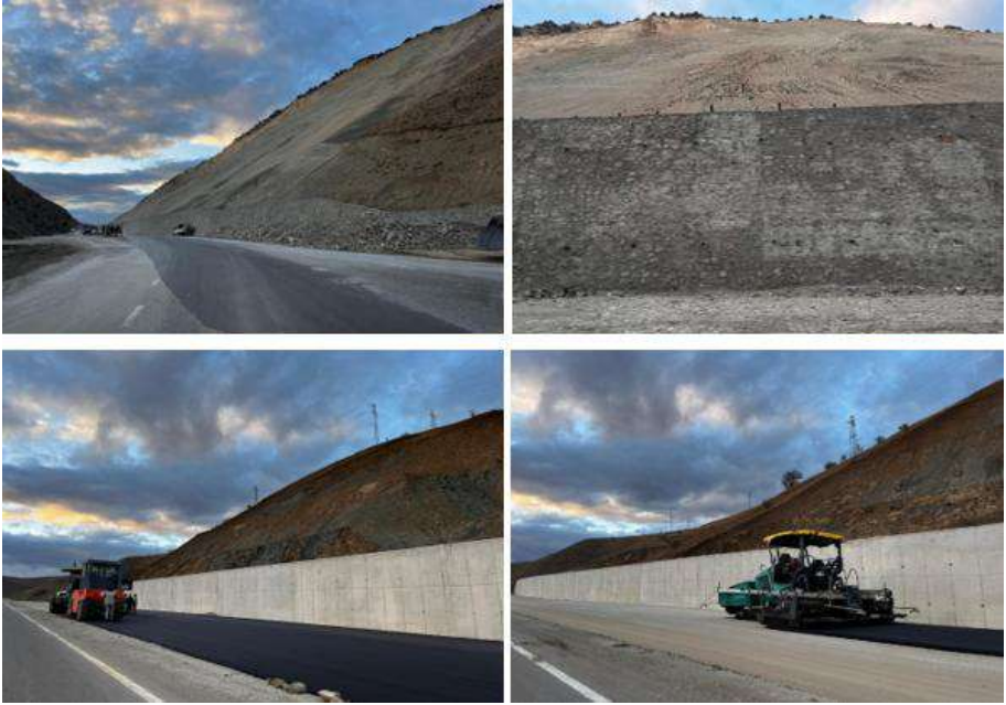
Şekil 6. Erzurum-Rize karayolu Rizekent mahallesi mevki heyelanlı bölgedeki yol yapım çalışmalarından görüntüler.
