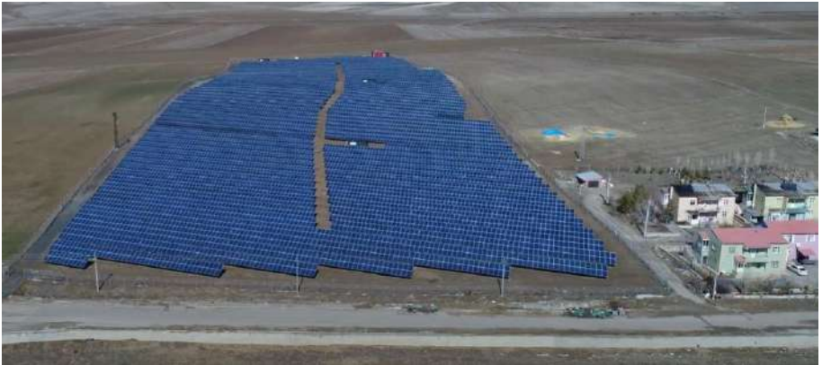
Şekil 6. Tarım Arazisi Üzerine Kurulmuş Güneş Panelleri
