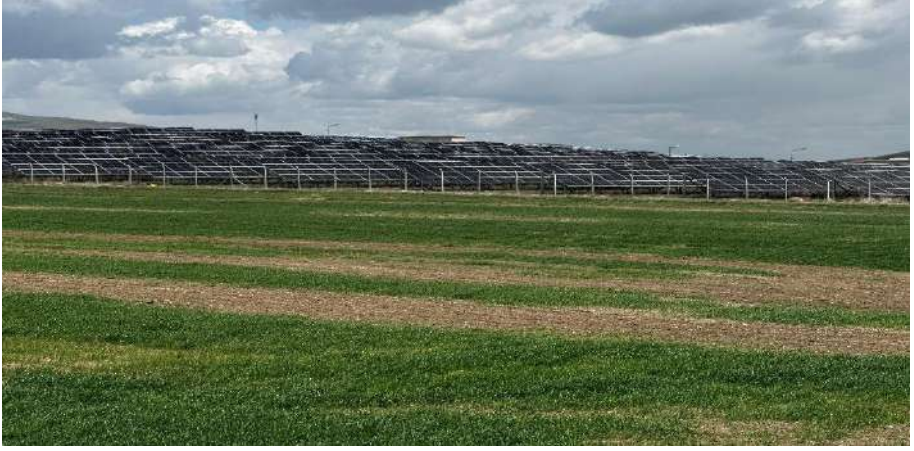
Şekil 5. Tarım Arazisi Üzerine Kurulmuş Güneş Panelleri
