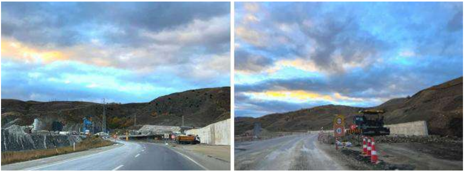
Şekil 8. Dallıkavak Tüneli inřaat alanı ve yol genişletme çalışmalarından görüntüler.
